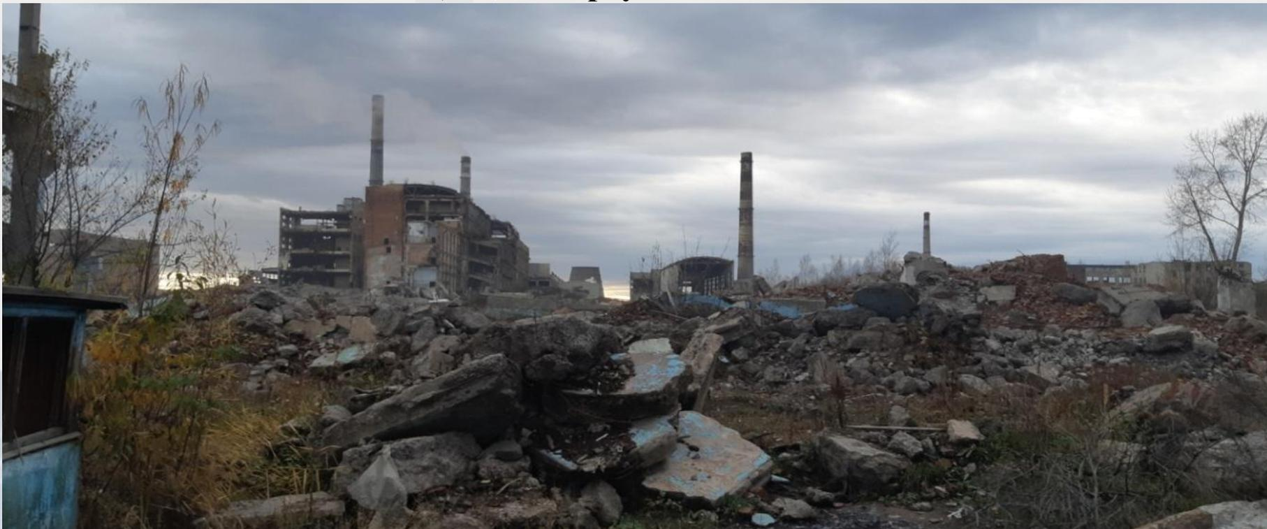
**Рисунок 4 — Скопление обломков перекрытий второго этажа и др., с чрезвычайно загрязненным ртутью грунтом первого этажа (ноябрь, 2022 г.).**
